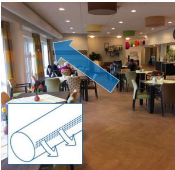
Figuur 15: Airsock van textiel langs de gevel van een restaurant in een van de zorggebouwen
