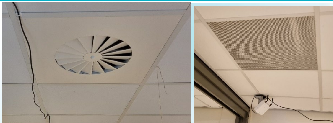
Links: Wervelrooster voor toevoer. Rechts: Afvoerrooster
