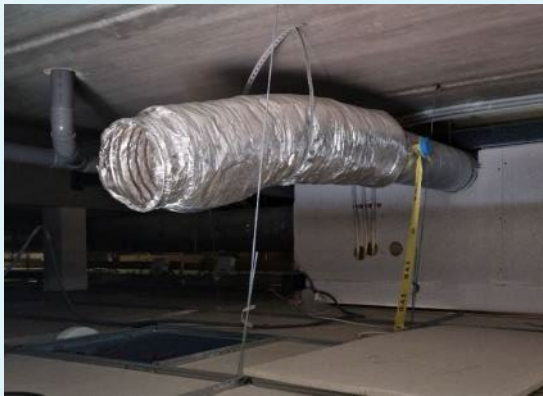
Linksboven: Geperforeerd toevoerrooster in de onderzoeksruimte. Linksonder: Flexibel afvoerpunt A2 boven het verlaagde plafond.. Rechts: Het toevoerpunt zoals te zien boven het systeemplafond.
